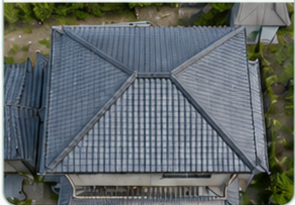
屋根全体の俯瞰画像
