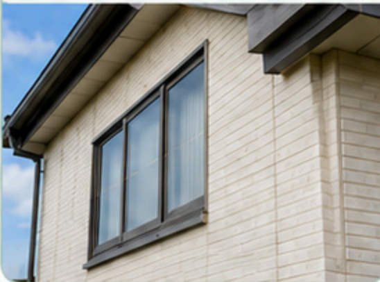
外壁・窓まわりの確認画像
