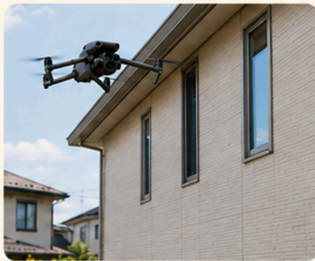
✓ 外壁・窓枠調査
